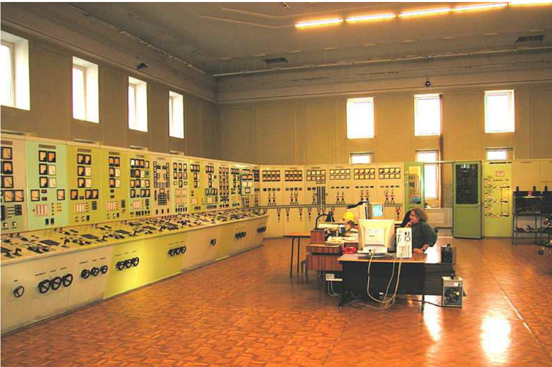
Widok na nastawnię przed modernizacją.
